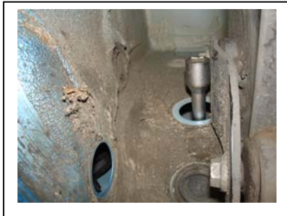
Demontage der Bolzen Grundträger
